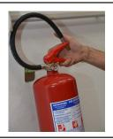
Nehmen Sie den Feuerlöscher aus der Halterung und prüfen: Stabilität der Befestigung der Halterung selbst, Sauberkeit und allgemeinen Zustand. Prüfen Sie das Kennzeichnungsschild und Markierungsetikett und ersetzen Sie es, wenn beschädigt. Entleeren Sie das Löschmittel vollständig aus dem Feuerlöscher mit geeigneten Auffanggeräten.
